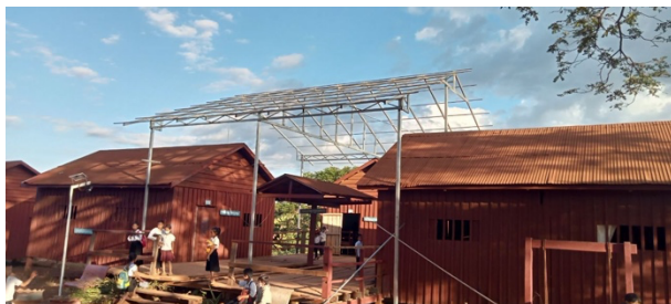
Fortschritt bei der neuen Überdachung
