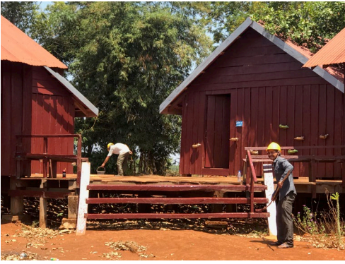
Primarschule Tong Kropu Vong wird renoviert. Kambodscha.
