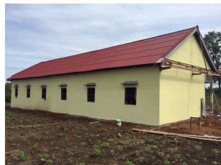
Kambodscha: Das Schulhaus ist bald bezugsbereit.
