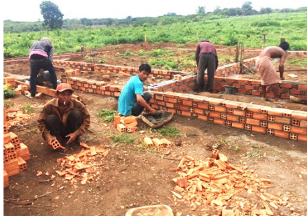
Kambodscha: Modernes bauen! Sekundarschulhaus Turn.
